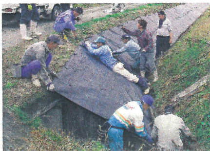
防草シートを設置する様子
